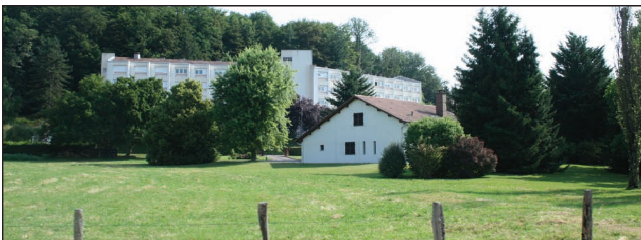
Maison isolée - rue du Coignot - 2013
