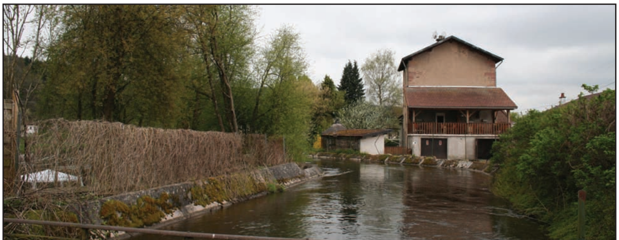
Canal d'alimentation en coeur de commune - 2013
