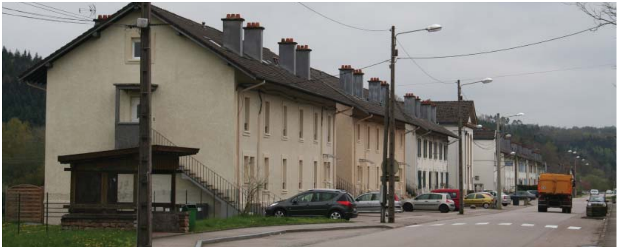
Les cités ouvrières, Rue de la Filature - 2013
