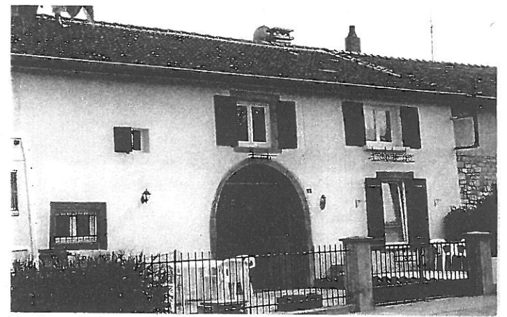
Construction de la rue de Solenval avec privatisation de l'espace usoir.
