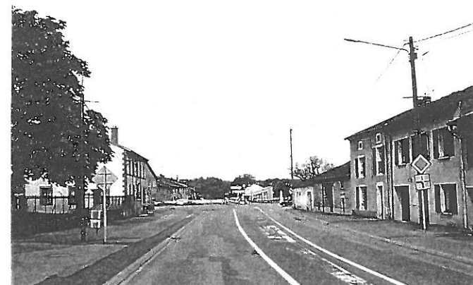
Puis, la rue dessert des constructions anciennes et une perspective s'ouvre sur la "Grande Rangée".
