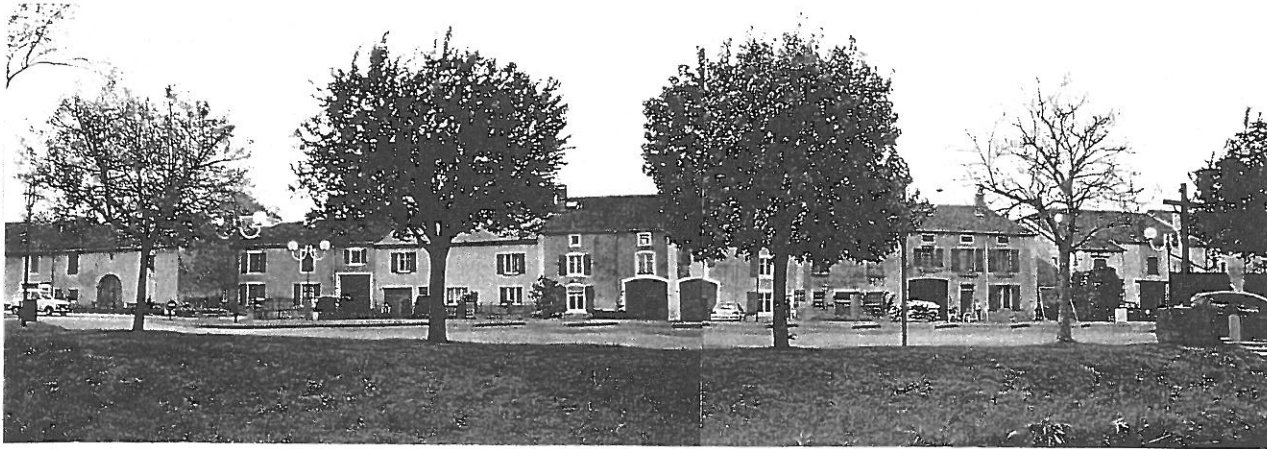
La "Grande Rangée" constituée de maisons lorraines traditionnelles a conservé son front bâti continu.
