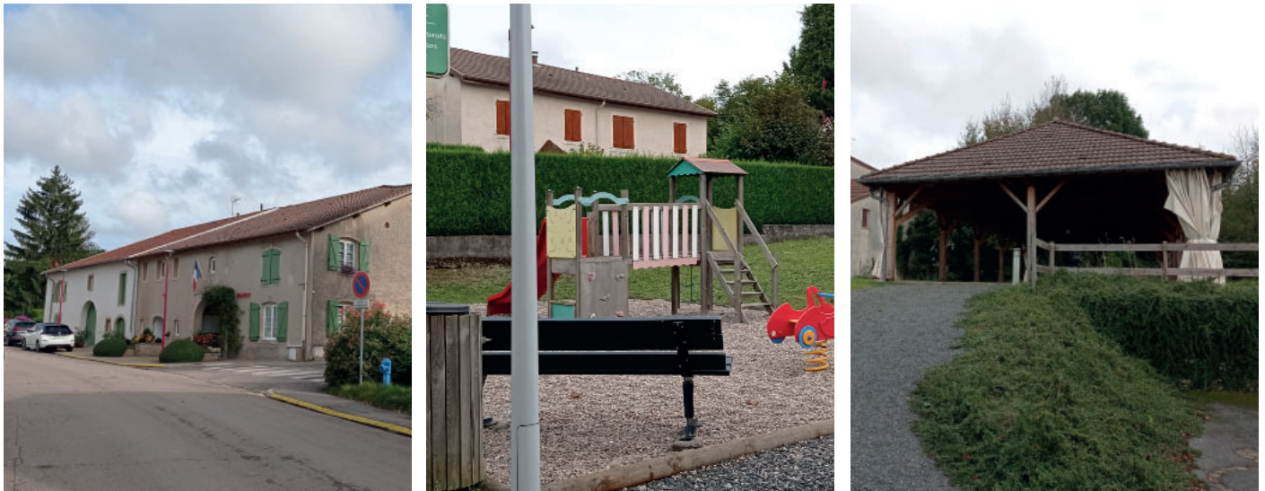
De gauche à droite, mairie avec logements collectifs dans le second corps de bâtiment ; aire de jeux, halle - photographie éolis 2020
