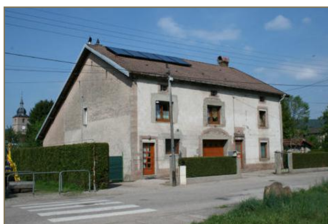
Rénovation maladroite d'une ferme ancienne - 2012
