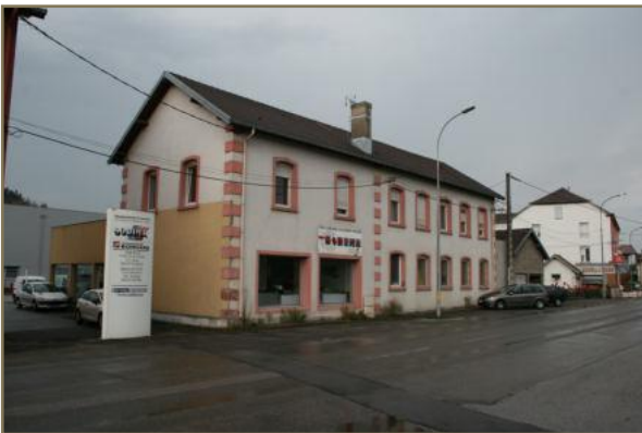
Magasin SODIMA rue de la Gare dans les anciens bâtiments de l'industrie textile - 2011
