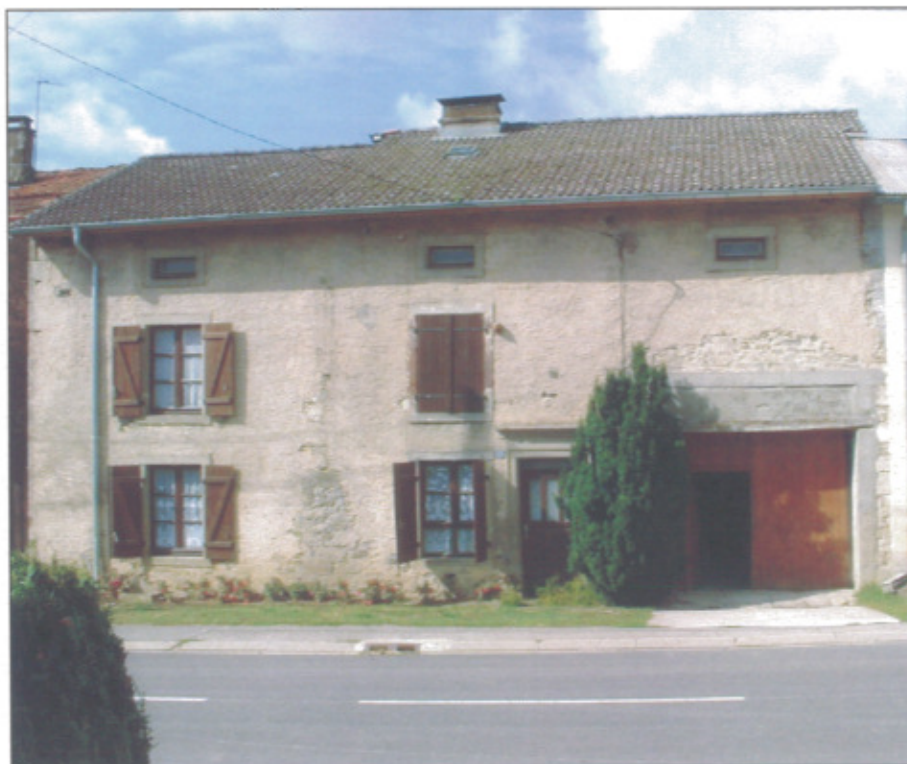
Une ferme lorraine en bon état. La porte de grange, à l'origine cintrée, a été baissée cependant la pose d'un linteau horizontal en bois reprend l'esprit traditionnel.
