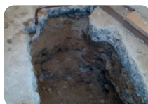
Réalisation de l'excavation sous dalle
