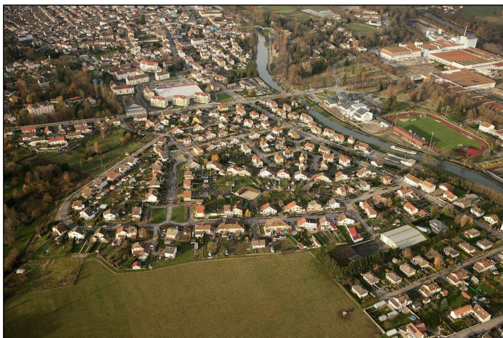
Vue aérienne (2008) Cité de La Marseille, Rotonde, BTT
