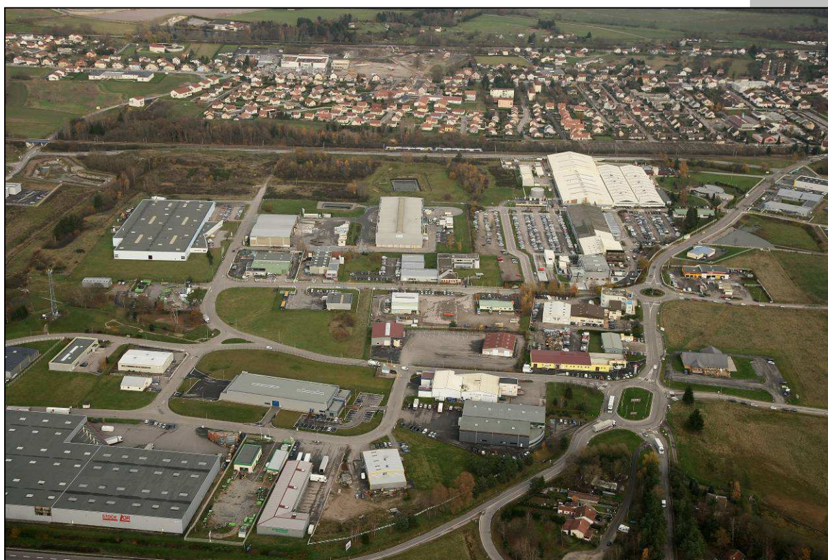
Zone Inova 3000 vue du ciel en 2008, mairie de Thaon-les-Vosges
