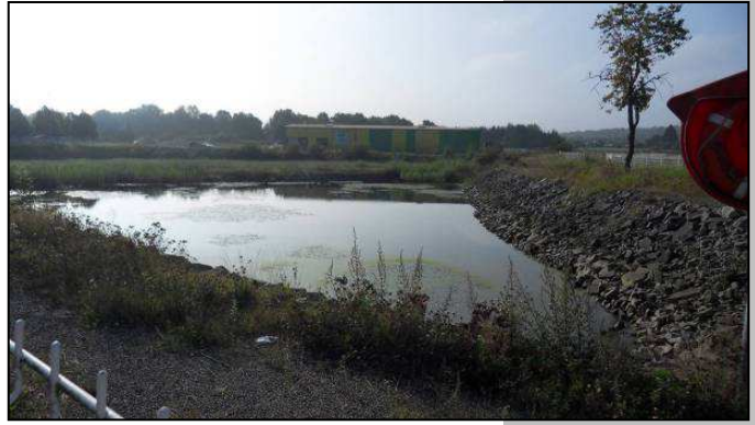
Bassin de rétention Inova 3000
