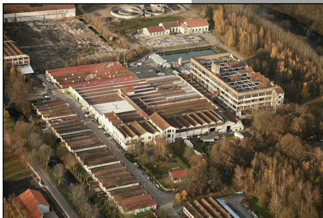
Site de la BTT : dépollution et desserte à étudier, état des ouvrages à considérer dans le projet avant ouverture à l'urbanisation
