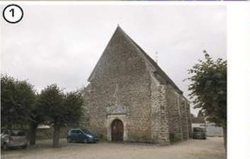
L'Eglise Sainte-Barbe du XIIème siècle et refaite au XVème dans le style flamboyant
