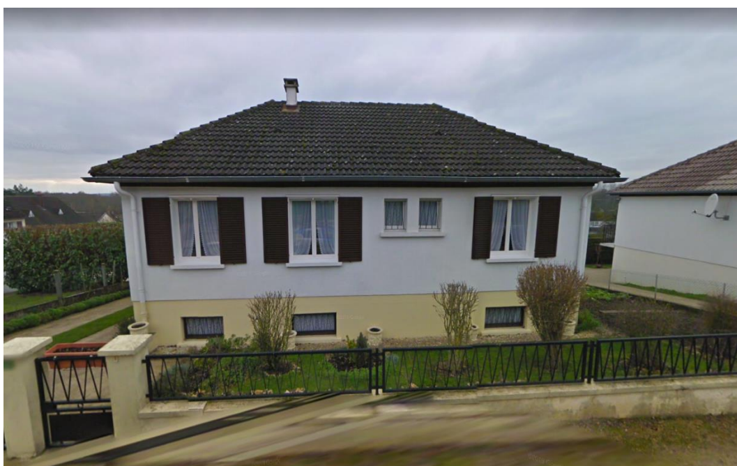
Figure 28 : Photographie d'une habitation caractéristique des lotissements, située 11 rue Auguste Renoir. Source : Google Street View
