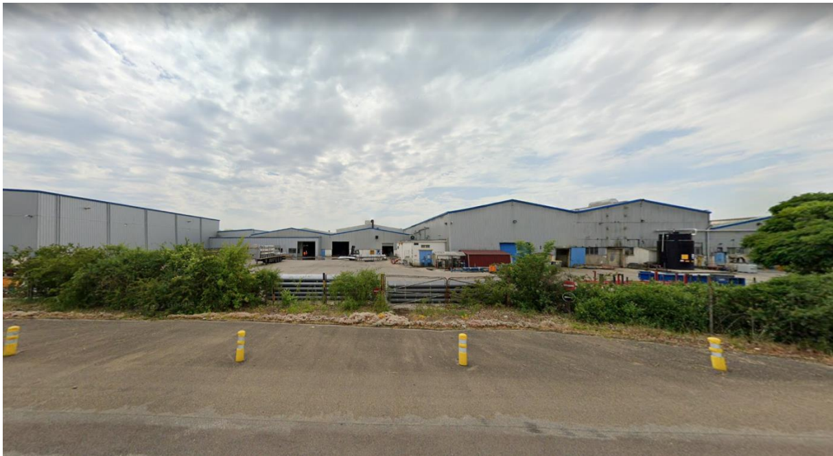
Figure 24 : Photographie d'un bâtiment situé dans la zone d'activité économique
