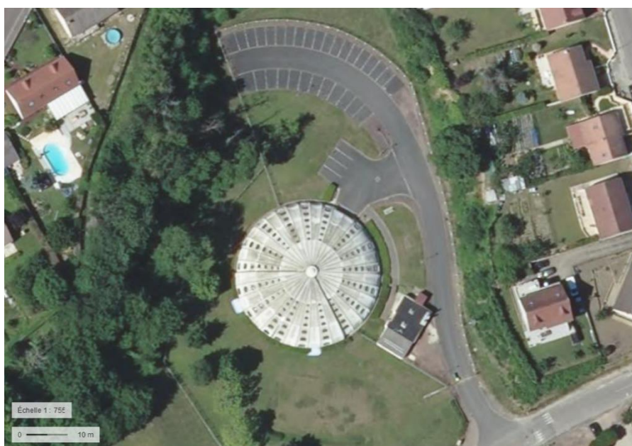
Figure 31 : Photographie aérienne de la piscine Tournesol située à Saint-Florentin. Source : Géoportail
