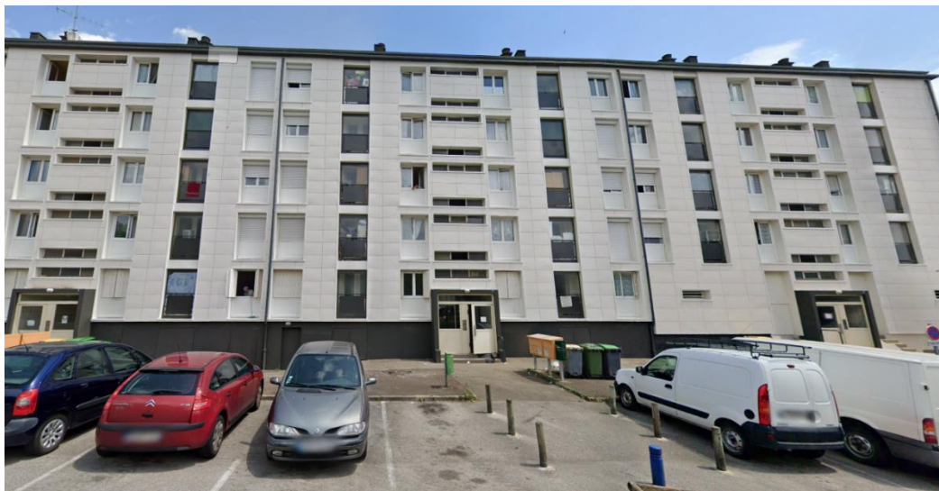
Figure 27 : Photographie d'une barre d'immeuble caractéristique des grands ensembles, située 6 avenue de l'Europe. Source : Google Street View
