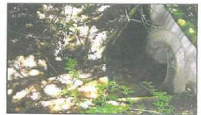
Fossé côté sud-ouest.
