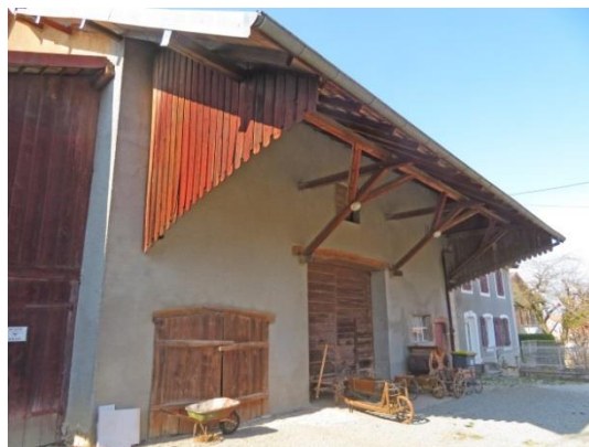
Avancée de toit sur aisseliers
