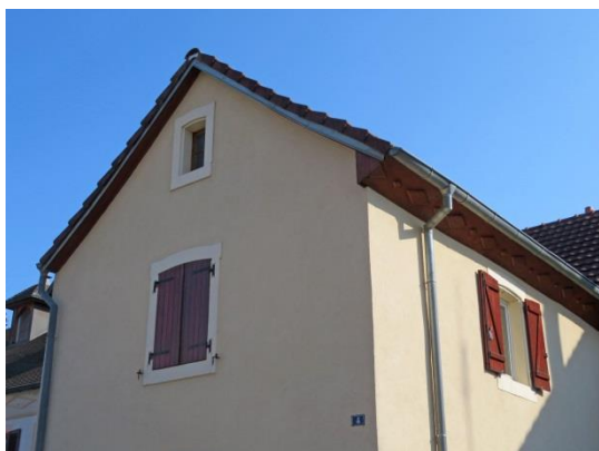
Corniche ou sous-face de toit
