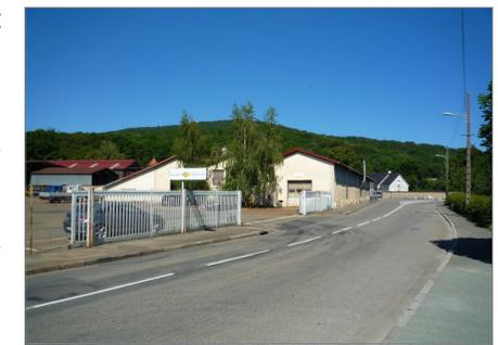
Le bâtiment de 1925, rez-de-chaussée construit en moellon de calcaire enduit et couvert de toits à longs pans en tôle
