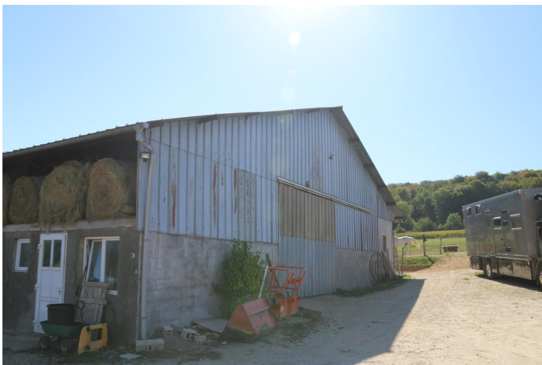
Le bâtiment agricole existant
