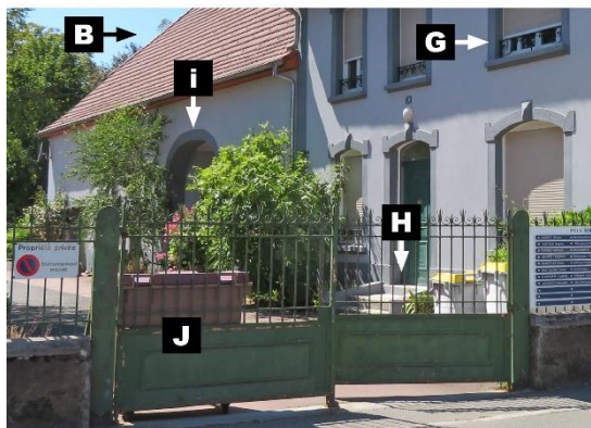
Détails de façade
