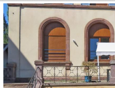
Exemple de baie en plein cintre
