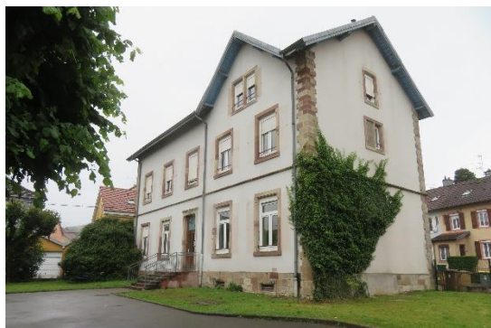
Façade sur jardin (Sud-Est)
