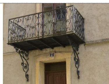
Consoles en fer forgé soutenant un balcon
