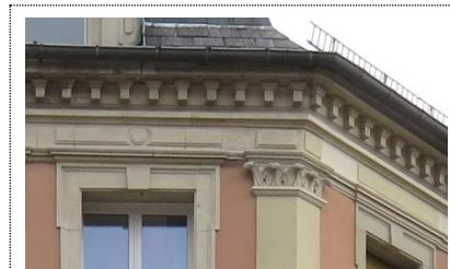
Exemple de modillons d'une corniche
