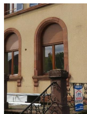
Imposte pleine au-dessus d'une fenêtre
