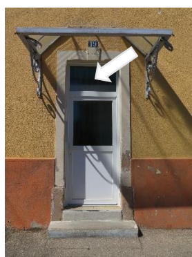
Imposte vitrée au-dessus d'une porte
