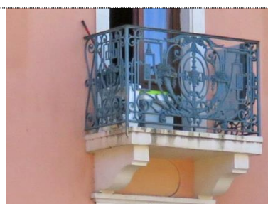
Consoles en pierre soutenant un balcon
