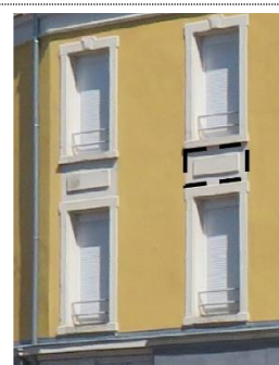
Exemple d'allège avec modénature
