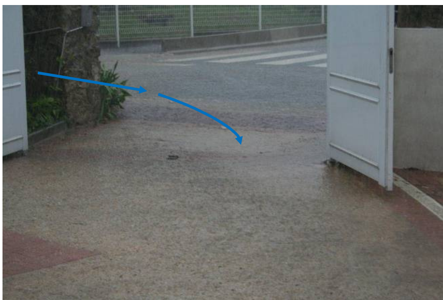
Photo 8 : Entrée des eaux en provenance du centre-ville chez un particulier
