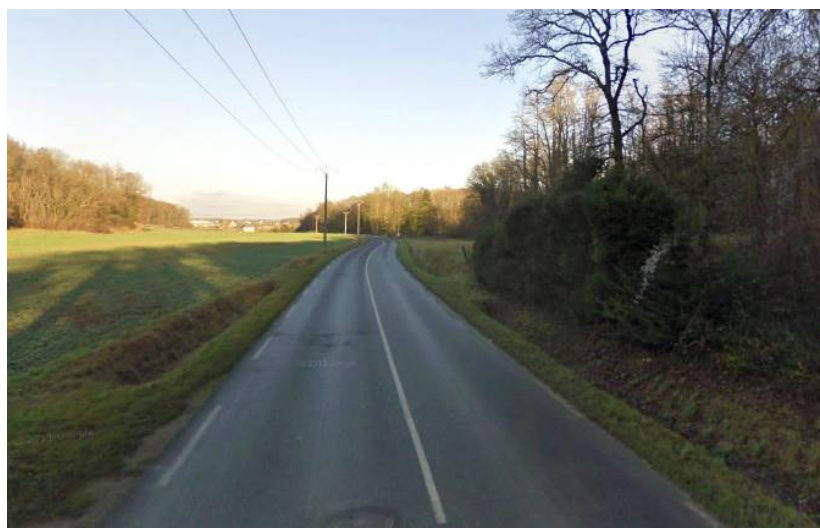
Photo 2: La RD56 en aval du hameau de Boinvau bordée de ses fossés qui peinent à être alimentés
