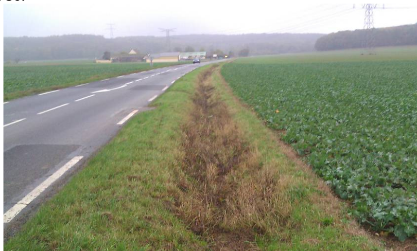
Photo 1 : Fossé inactif de la D56
