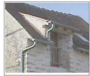
Exemple de lucarne engagée rampante
