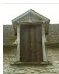
Exemple de lucarne engagée à fronton
