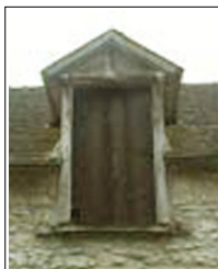
Exemple de lucarne engagée à fronton
