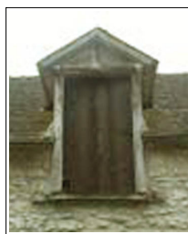
Exemple de lucarne engagée à fronton
