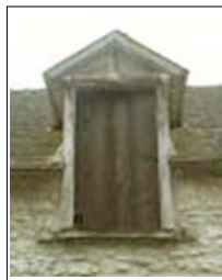
Exemple de lucarne engagée à fronton
