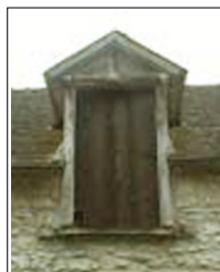
Exemple de lucarne engagée à fronton
