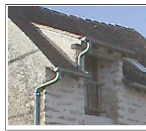
Exemple de lucarne engagée rampante
