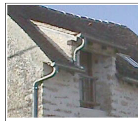
Exemple de lucarne engagée rampante
