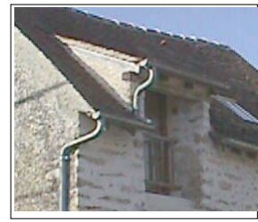
Exemple de lucarne engagée rampante
