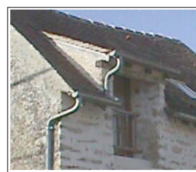
Exemple de lucarne engagée rampante
