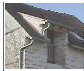
Exemple de lucarne engagée rampante
