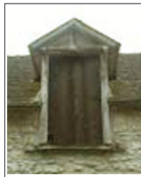
Exemple de lucarne engagée à fronton
