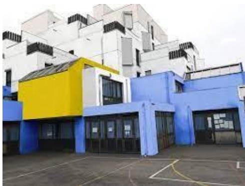
Source. Ville d'Evry-Courcouronnes. Ecole Jules Verne, concernée par un projet de réhabilitation débuté en 2022.
