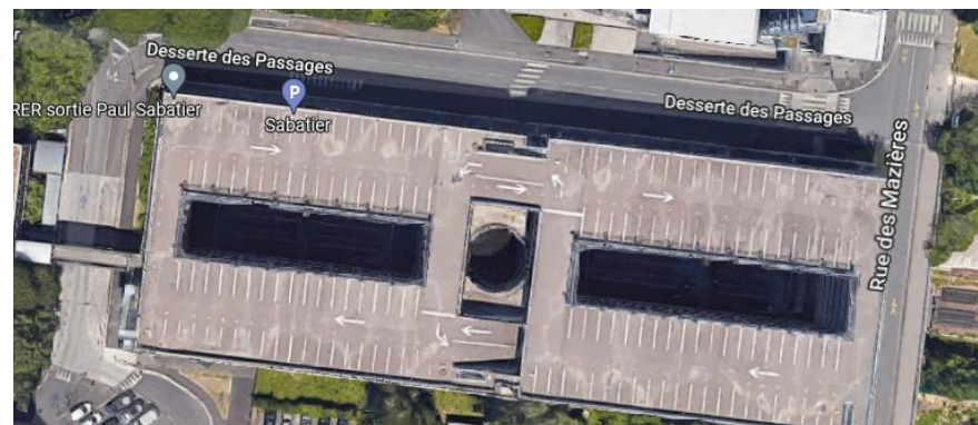
Parking Sabatier (Gare RER) : Parking en structure, entrée desserte des Passages d'Évry-Courcouronnes-Centre. 863 places . 2€ de l'heure. (EFFIA)
