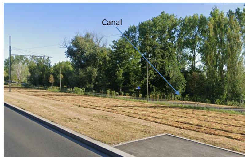
Le canal du bois Briard, peu visible depuis la RD446 (Google Maps)
