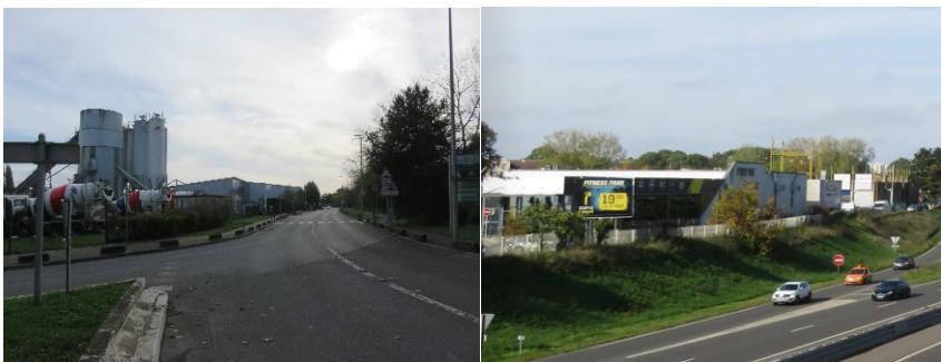
Zone portuaire et zone d'activités le long de l'autoroute du Soleil
