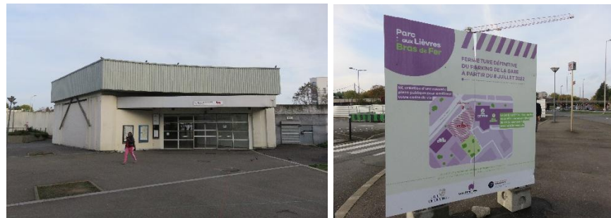
Entrée gare Bras de Fer, actuellement concernée par des travaux de requalification
