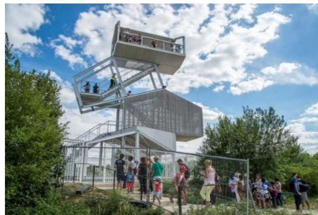
PARC ALLUVIAL DU PEUPLE DE L'HERBE (CARRIERES-SOUS- POISSY) – SOURCE : AGENCE DE L'EAU SEINE NORMANDIE
