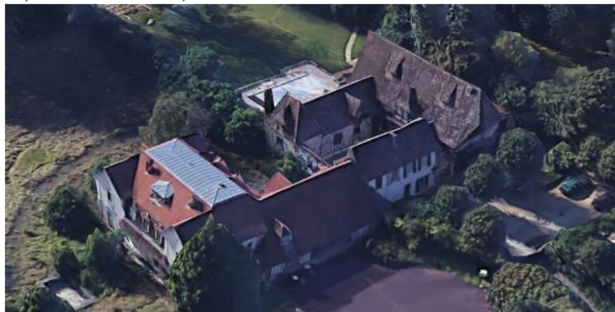
11/ L'ancienne ferme, avenue de Beauvoir
