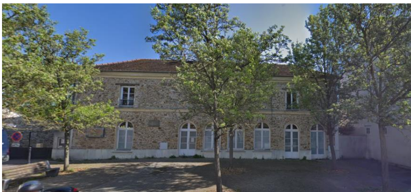
14/ L'ancienne mairie-école, 15 boulevard Aguado
