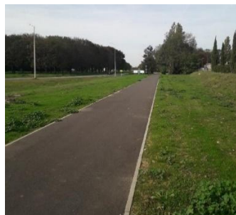
Création d'une voie verte le long de la RD446 à Evry-Courcouronnes.
