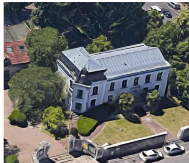
28/ Bâtiment Layellon, Carrefour Paul Puech / rue de Versailles
