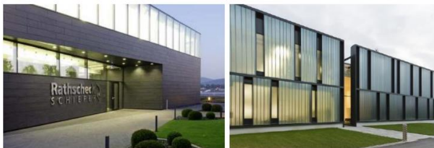
Exemples de mise en lumière de bâtiments d'activités – Source D&A, 2021
