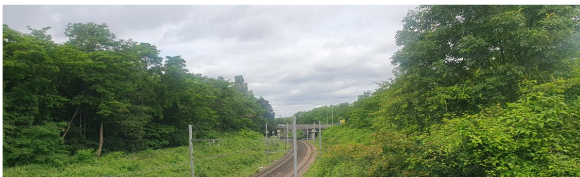
Vue de l'emprise du site depuis la passerelle piétonne
