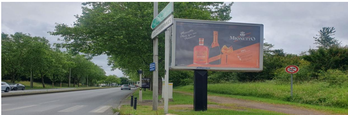
Vue de l'emprise du site depuis le N449 au Nord du projet
