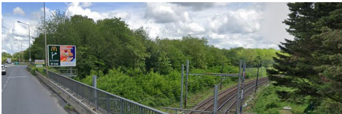
Vue de l'emprise du site depuis le N449 sur le franchissement de la voie ferrée
