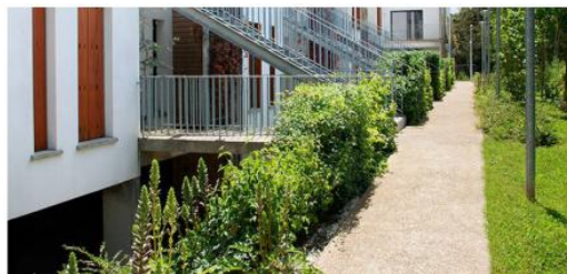
Systèmes de parkings semi-enterrés à Bayonne
