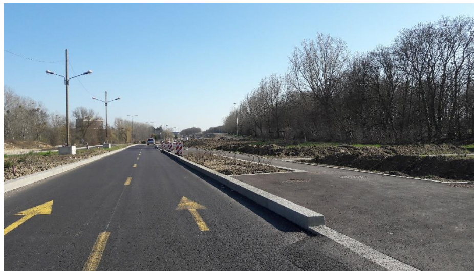
Figure 26 - Vue n°2 à la sortie du rond-point du Traité de Rome
