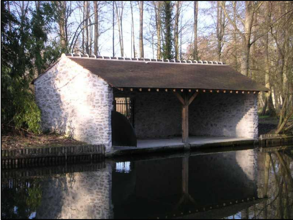
Lavoir dans le Parc communal
