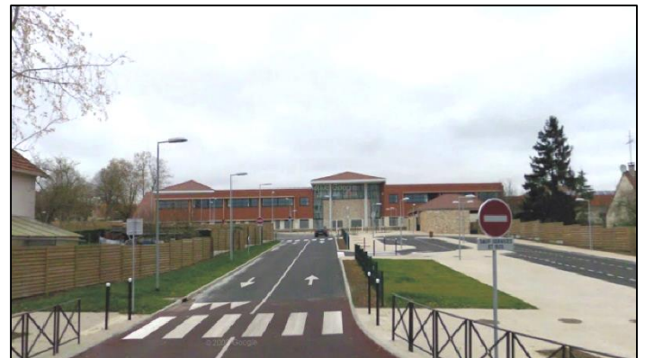
Bel aménagement de l'espace public aux abords du collège
