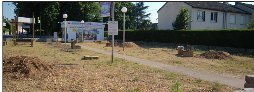
Le Square de Plaidt en cours de requalification
