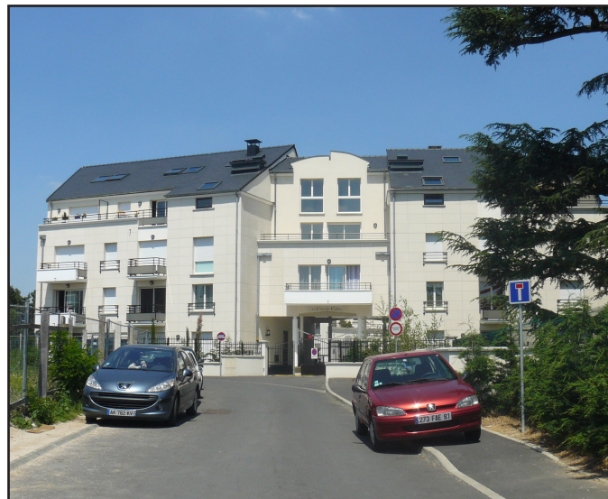
Habitat Collectif : avenue du Général Warabiot
