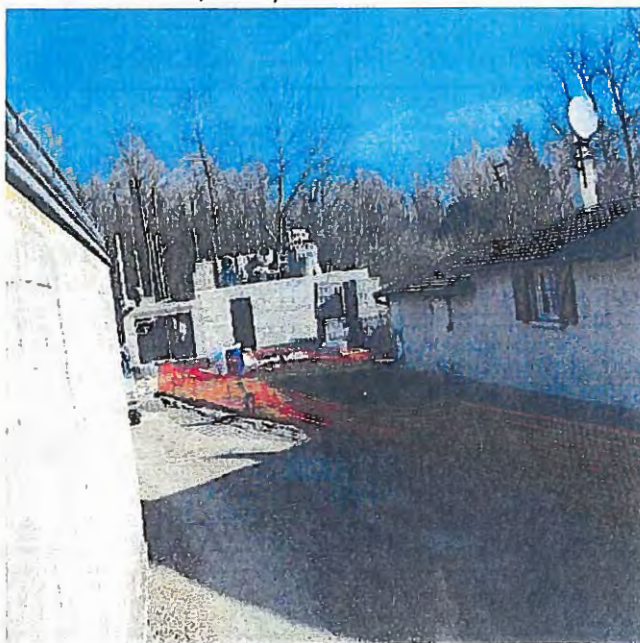
Pavillon en construction, fond de parcelle rue des Ponts
