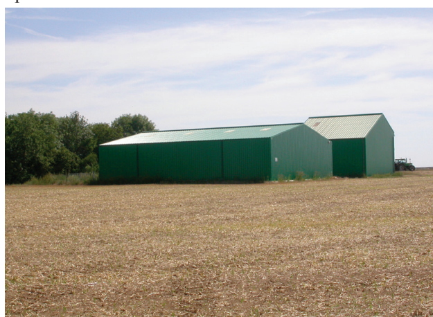
Hangars agricoles proches de la Rd 49 : intérêt d'une teinte homogène sur parois et couverture
