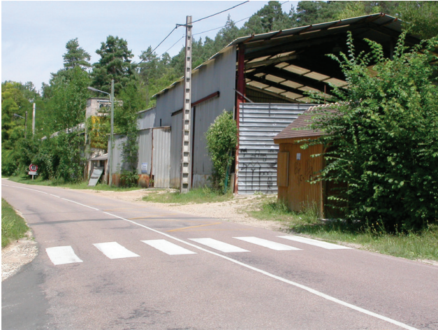
Ancienne usine Samson route de Méréville
