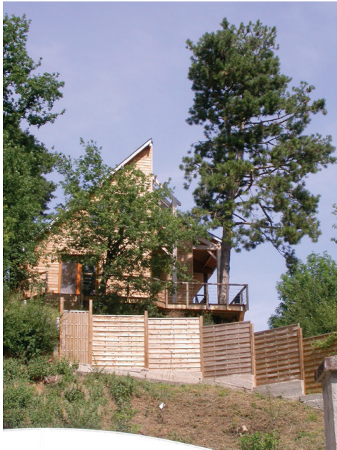
Construction en bois au Pont à Chat
