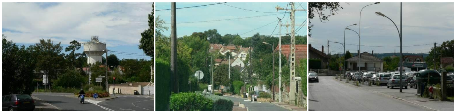
Vues vers le château d'eau et le bois du Mont Pipau, vers le bois des Roches et vers la ligne de crête du versant opposé de la vallée
