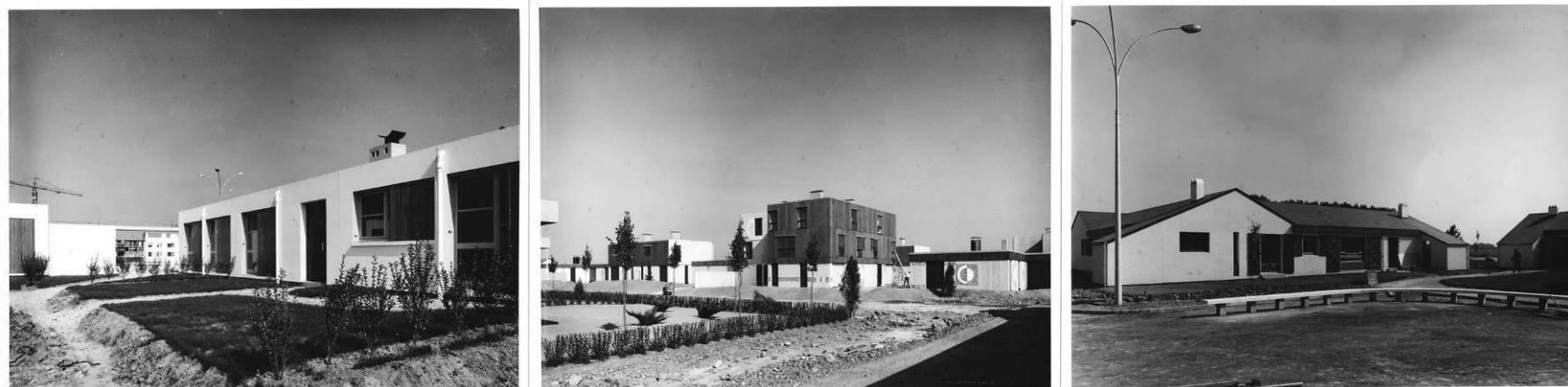
Maisons du Villagexpo au moment de la construction du quartier
