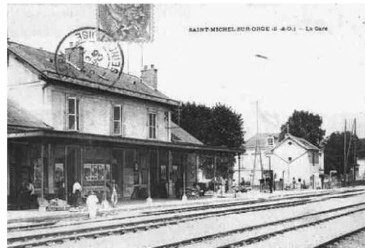
La gare de Saint-Michel-sur-Orge construite entre 1837 et 1843
