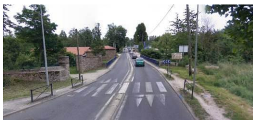
Vue sur le pont au dessus de l'Orge depuis Longpont-sur-Orge
