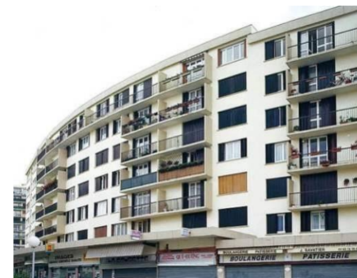
Ensemble collectif du Bois des Roches bâti dans les années 1960
