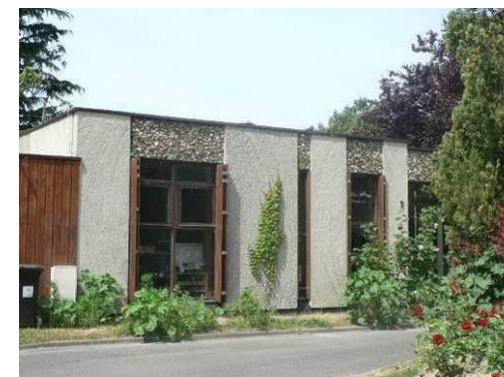
Maison de Villagexpo construite au début des années 1960
