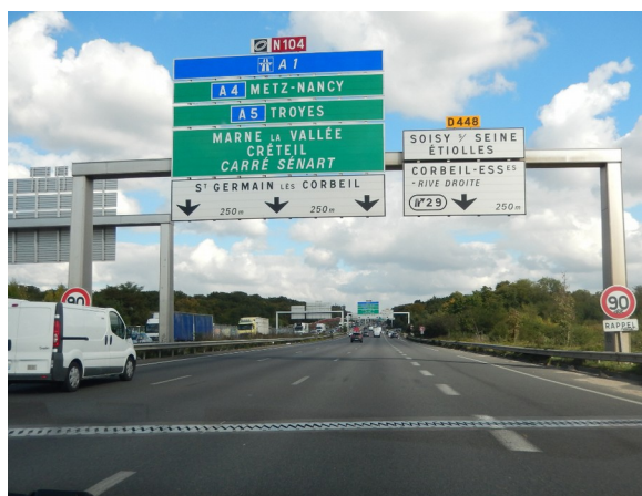
Illustration 19: Élargissement de la RN104, source DDT91
