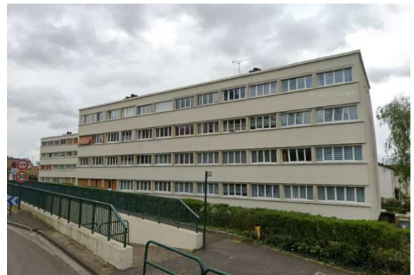
Immeuble collectif – Rue d'Estienne d'Orves
