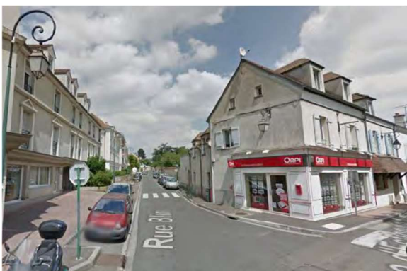
Maisons de ville Centre-ville – Rue Blin
