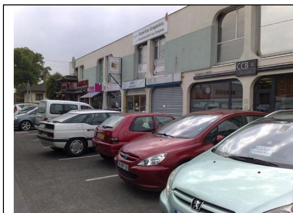
Pôle de services Route de Corbeil
