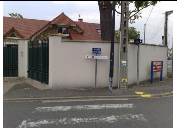
Mur recouvert d'un crépi Avenue des Rouges Gorges
