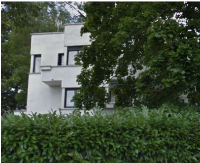
1 Avenue de Beauvillier
