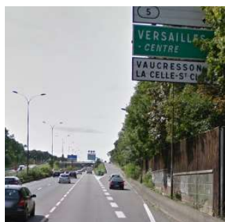
A13 sortie Vaucresson Garches
