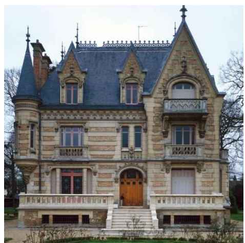
30, allée Saint-Gilles, 7, place du Général Leclerc
