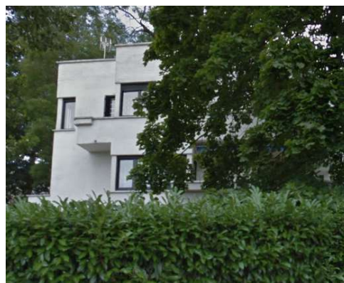
1 avenue de Beauvillier
