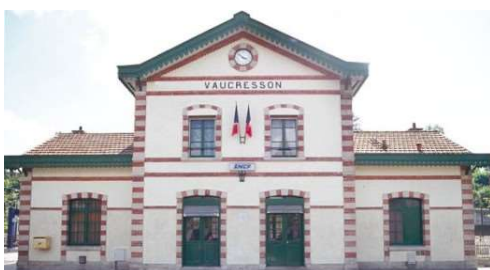
Place de la Gare
