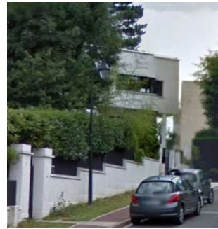
3 Avenue de Beauvillier
