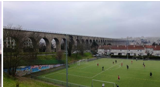
Vue sur l'aqueduc de la Vanne
