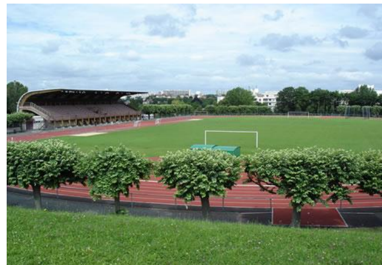
Centre sportif Louis Frébault – source : ville d'Arcueil
