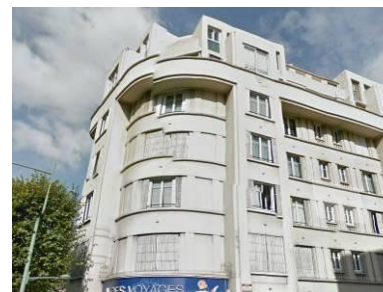
Immeuble situé avenue Laplace – source : google maps / streetview
