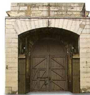
Porte d'entrée du Fort de Montrouge Source : Tigris / Flohic Editions, œuvre collective
