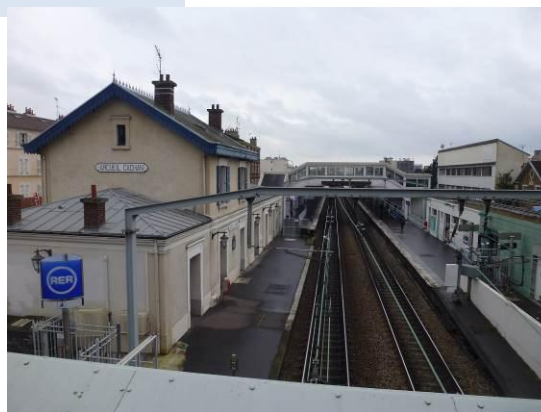
Gare Arcueil- Cachan depuis la passerelle
