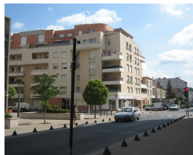
Nouveaux logements (quartier du docteur Roux)
