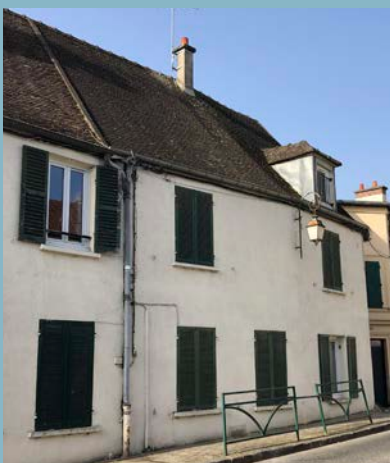
Toiture à tuiles plates au centre-ville ancien.
