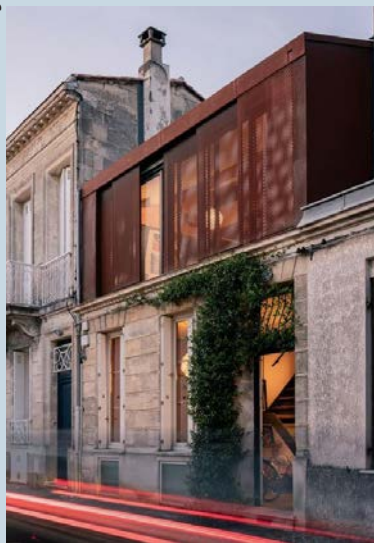
Surélévation - FELAA ARCHITECTES
