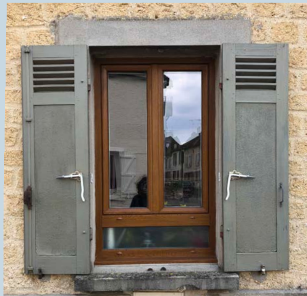
Persiennes en partie haute au rez-de-chaussée
