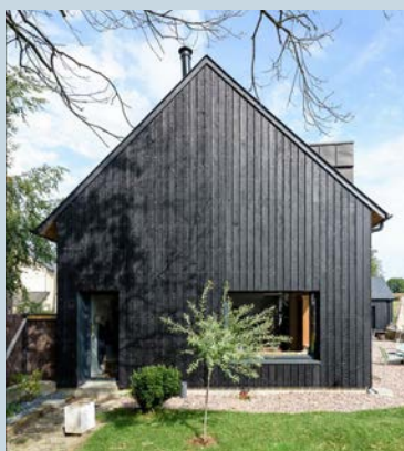
Extension bois bardage brûlé Architectes Briand- Renault
