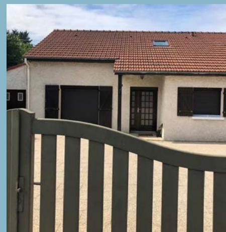
Toiture à tuiles mécaniques secteur Nord-Ouest.
