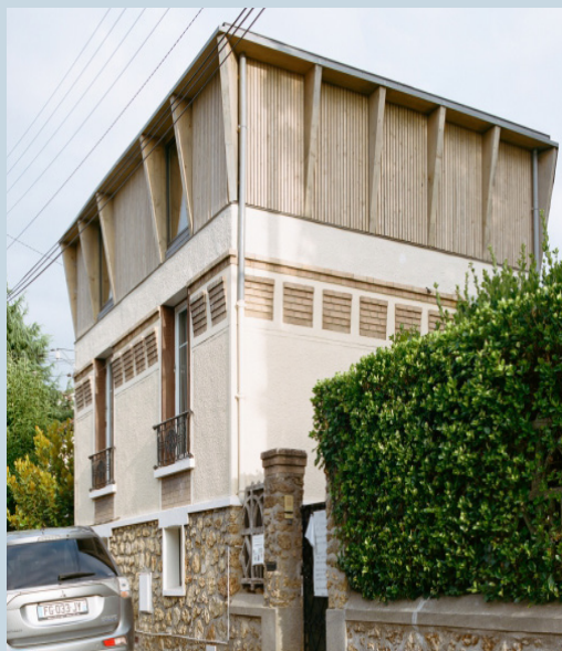
Surélévation d'une maison meulière, Benoît Rotteleur Architecte
