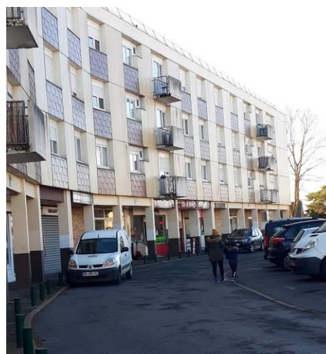
Commerces au rez-de-chaussée du collectif Route de Creil
