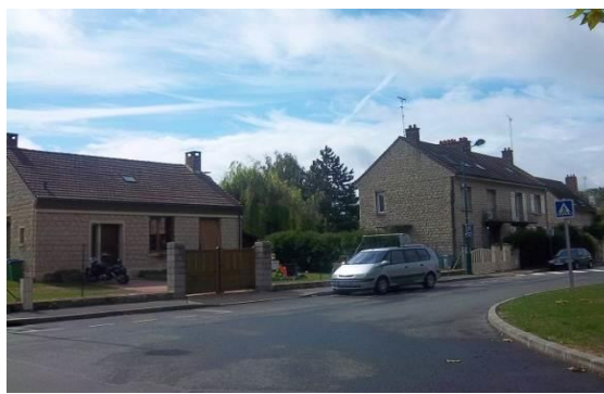
Habitations rue de l'église
