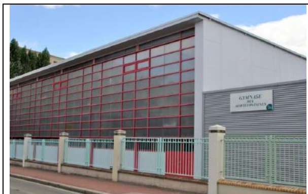
Gymnase des Mortefontaines Rue Eugène Lamarre
