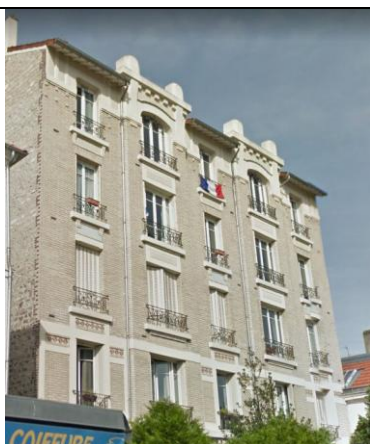
Immeuble en pierre et en brique Avenue de la Division eclerc
