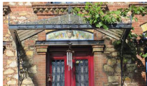
Exemple de marquise à préserver
