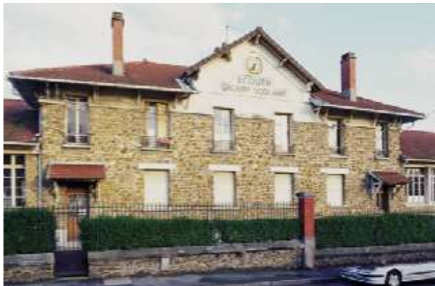
12 avenue du Maréchal Foch Groupe scolaire
