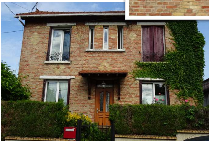
Exemple de façade en brique à préserver
