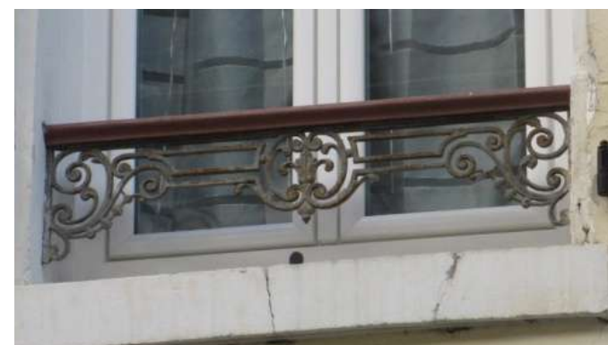
Exemple d'un garde-corps de fenêtre entre tableau de la fin du 19 ème siècle → à préserver
