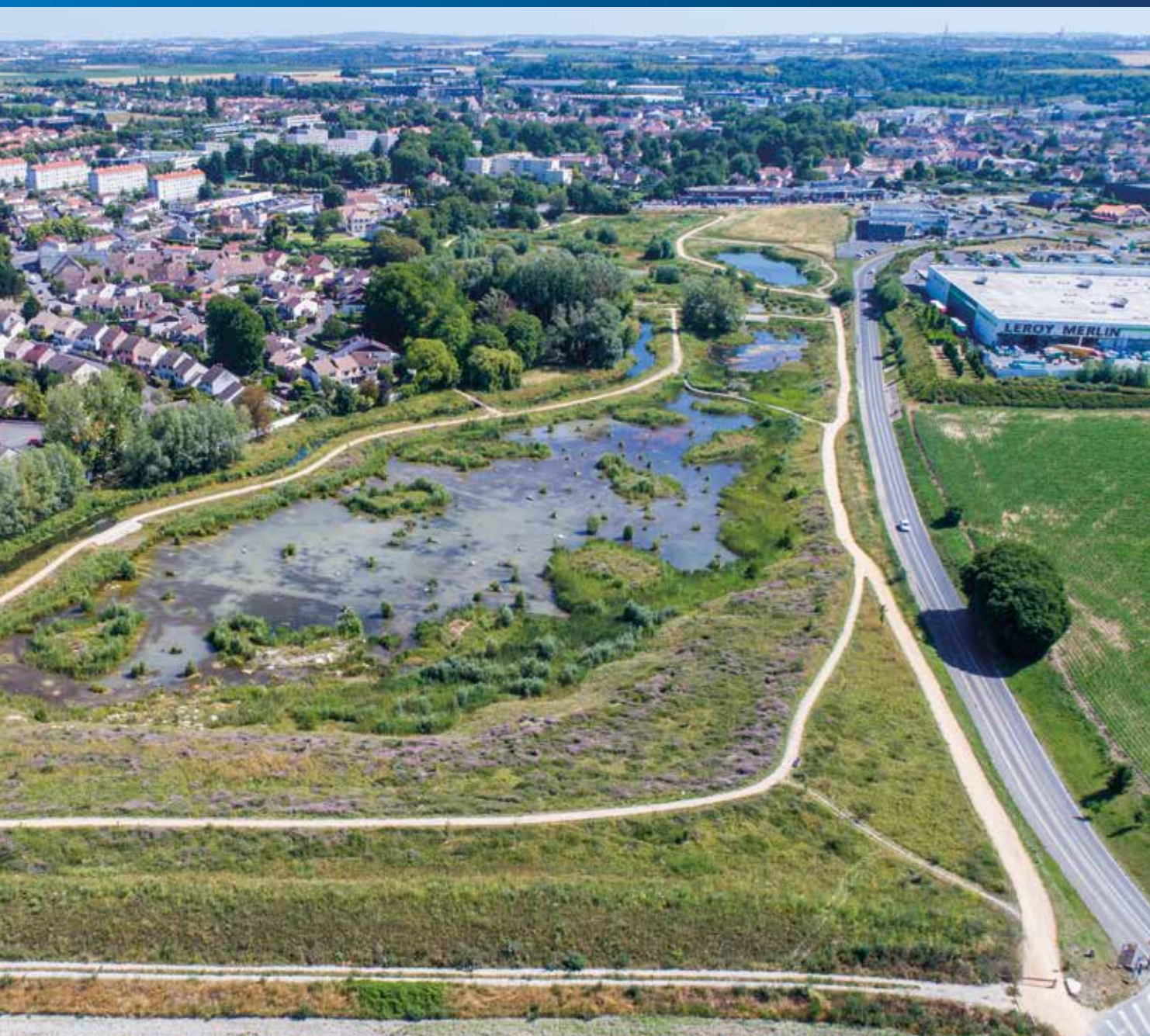
Zone d'expansion de crue du Vignois
