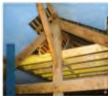
Installation d'un plancher
