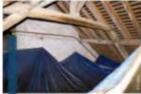
Bâches de protection dans un colombier
