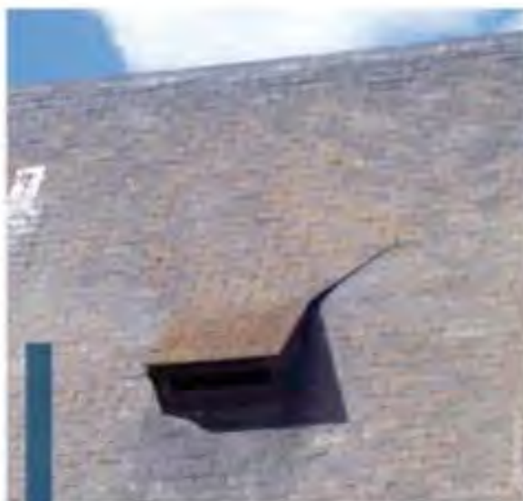
Chiroptière sur le toit d'une église
