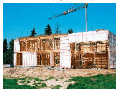
Chantier d'une maison à ossature bois
