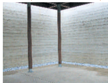
Préau aux Clayes-sous-Bois, archi. Anne Delaunay
