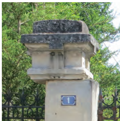
Recaler les pierres de chapiteau
