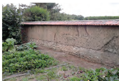
Mur de clôture en pisé
