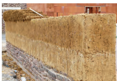
Mur en bauge en cours de construction
