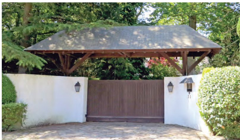
L'auvent marque l'entrée de manière monumentale et la protège de la pluie. Il doit être restauré en cohérence avec le style de la clôture et du bâtiment
