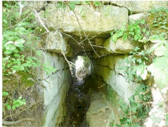
007-Ouvrage d'Art Etang de Gouline.jpg
