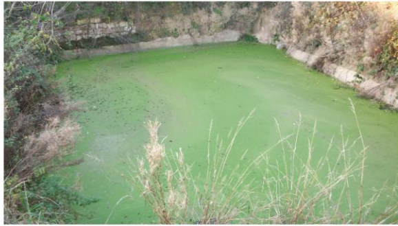
Bassin de récupération des eaux de ruissellement sur un plateau agricole, très riche en nitrates, et totalement envahi par la Petite lentille d'eau
