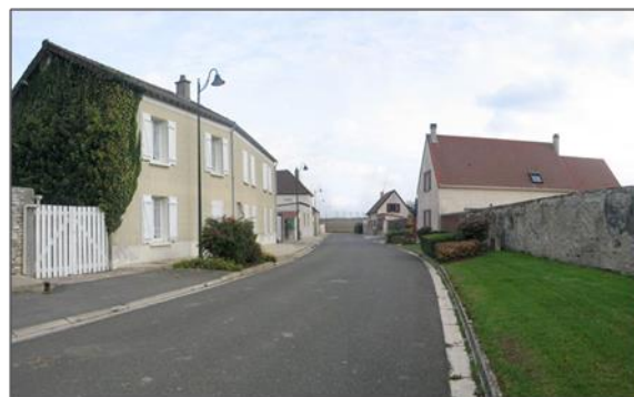
Figure 118 : Constructions récentes dans le village
