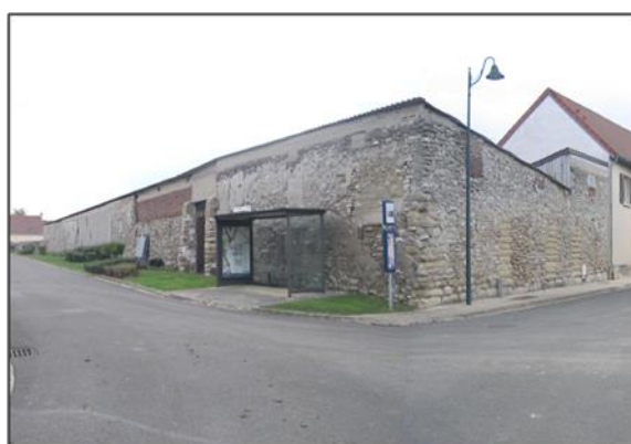
Figure 126 : Les hauts murs en pierre
