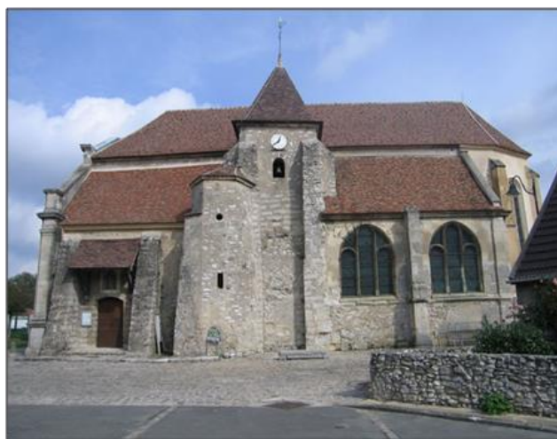
Figure 106 : Eglise classée du Plessis-Gassot
