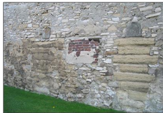
Calcaire utilisé pour les fondations,
