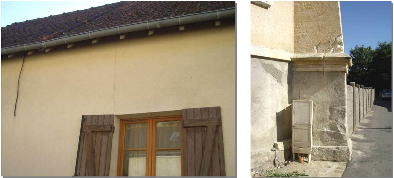
Figure 67 : Fissures apparues sur le bâti (g. rue des blancs manteaux, d. Église)
