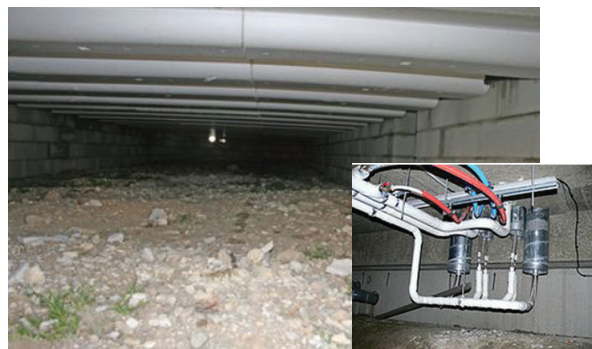
Illustration d'un vide sanitaire avec ses équipements
