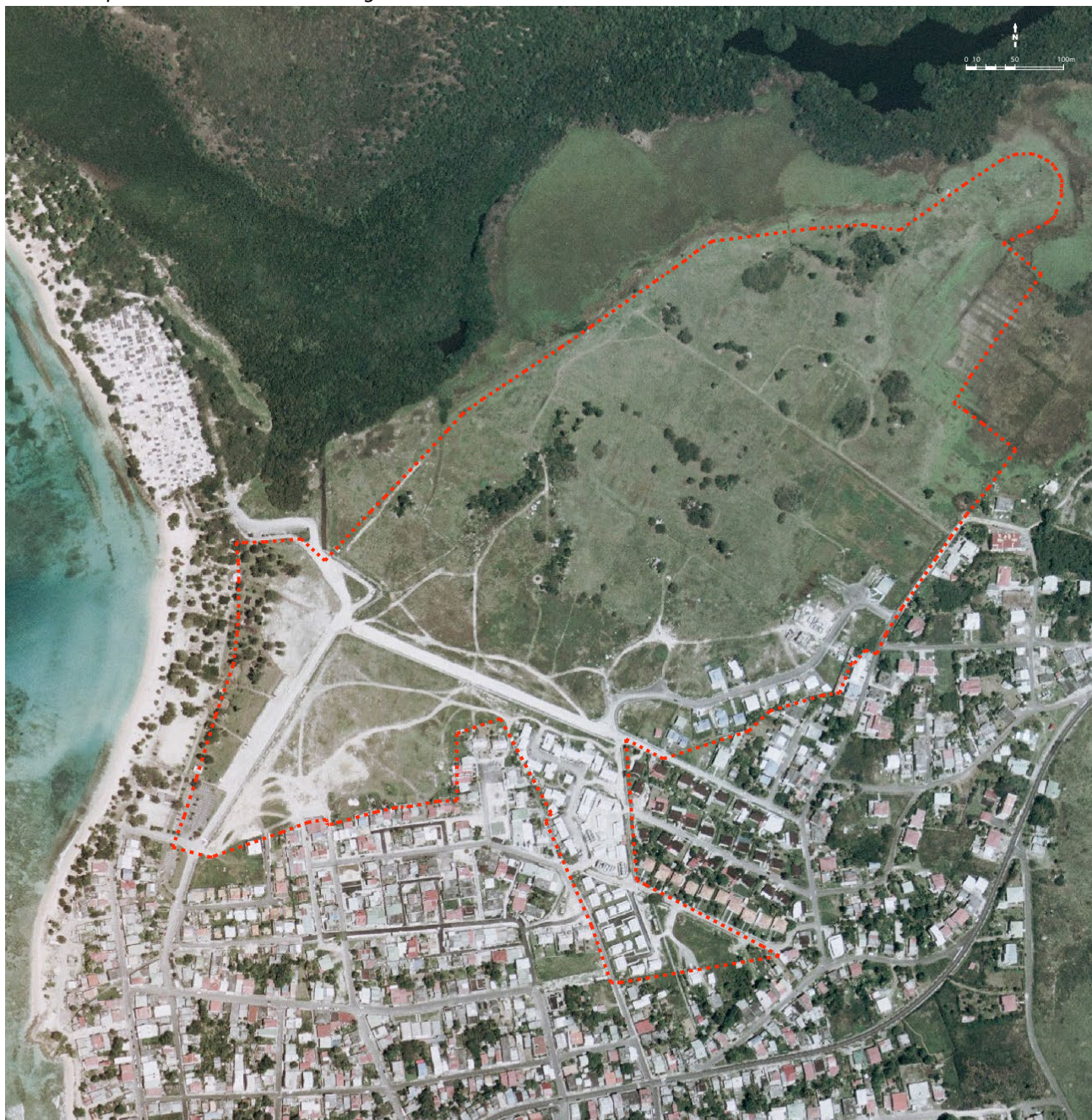
Périmètre opérationnel de la ZC de Rodrigue en cours de travaux
