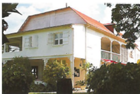
Maison principale de la distillerie Séverin
