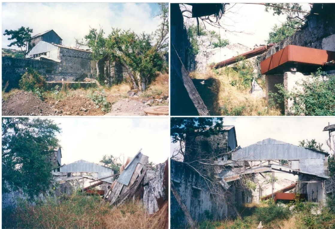
Clichés photographiques de 1993 montrant les ruines de l’usine sucrière avant sa destruction. Est présent sur ces clichés la cheminée en tôle effondrée suite au passage d’un cyclone (Sources : Crédit Photo, Martine AKHOUN, DAC-ol).
