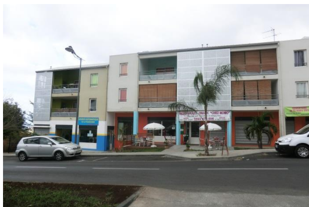
Commerces en rez-de-chaussée – Avenue Salvador Allende
