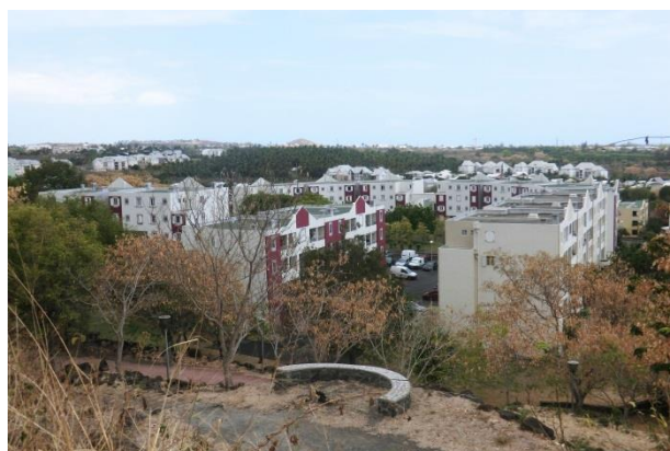
Immeubles d'habitat collectif rue Arthur Rimbaud
