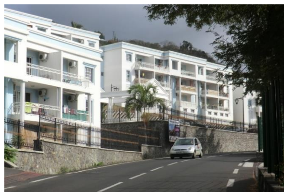
Immeubles à l'architecture trop éloignée de l'architecture traditionnelle ne facilitant pas leur insertion urbaine.
